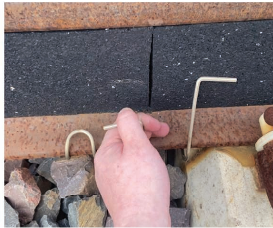
3. Przykład niewłaściwego przylegania izolatora przyszynowego [opracowanie własne]
