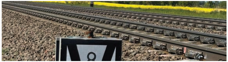
1. Przykład stosowanych tłumików szynowych montowanych na szycie szyny. Materiał własny
