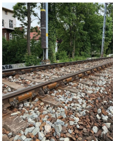
4. Polygon badawczy z przytwierdzeniem typu K (a) oraz z przytwierdzeniem typu SB (b) na LK nr 250 [opracowanie własne]
