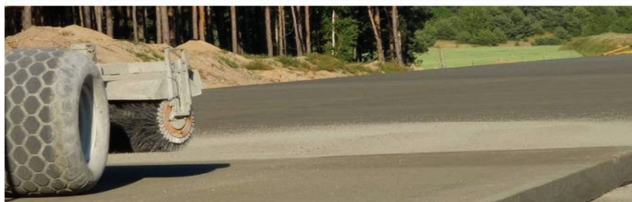
3. Widok nawierzchni wykonanej metodą „odkrywania kruszywa”, fot autorskie
