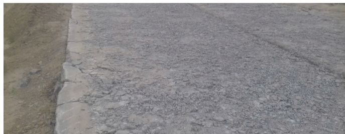
12. Ostatecznie rozdrobiona i zagęszczona powierzchnia po dwukrotnym przejściu walca wibracyjnego
