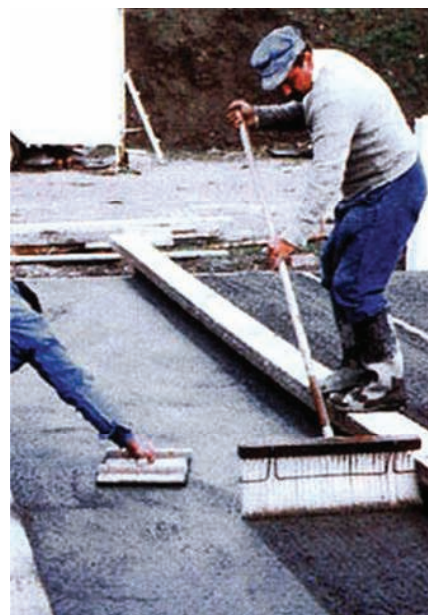
2. Przykłady teksturowania nawierzchni z wykorzystaniem szczotkowania oraz juty [1]
