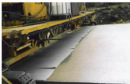
2. Przykłady teksturowania nawierzchni z wykorzystaniem szczotkowania oraz juty [1]
