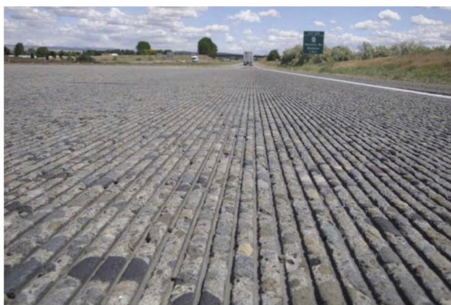
10. Widok nawierzchni wykonany w technologii groovingu [2]
