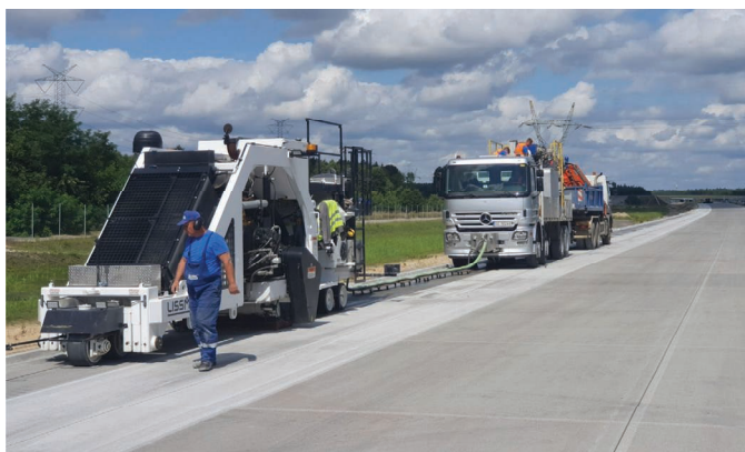
5. Zestaw do szlifowania i odsysania odpadów, fot. autorskie
