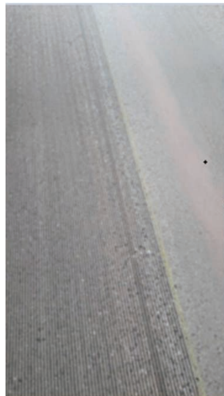
9. Widok nacięć podłużnych w technologii grindingu, fot. autorskie
