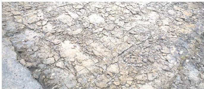
11. Powierzchnia pokruszonych płyt betonowych po przejeździe łamacza MBH
