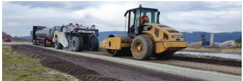
13. Wbudowywanie warstw MCE z innowacyjnym środkiem wiążącym
