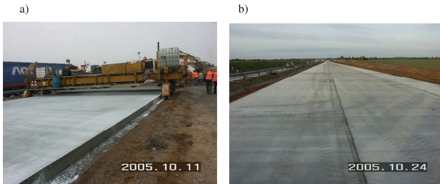
10. Budowa nawierzchni o ciągłym zbrojeniu a) układanie betonu; b) wykonana nawierzchnia
