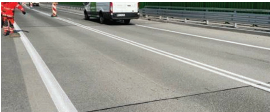
16. Widok nawierzchni betonowej na obiekcie mostowym (droga S7)
