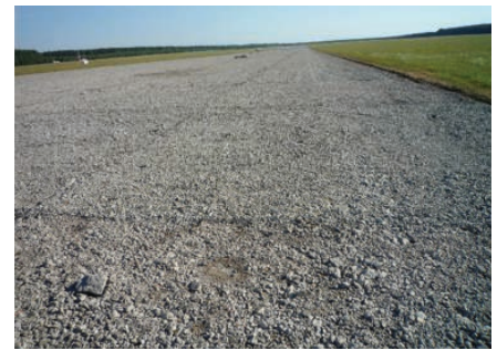
12. Odprężanie nawierzchni betonowej metodą rezonansową i widok odprężonej nawierzchni
