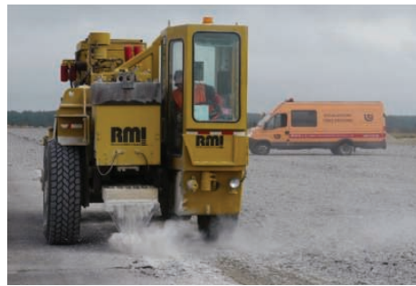
12. Odprężanie nawierzchni betonowej metodą rezonansową i widok odprężonej nawierzchni
