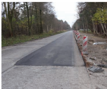
9. Warstwa SAMI ułożona na powierzchni skropionej emulsją
