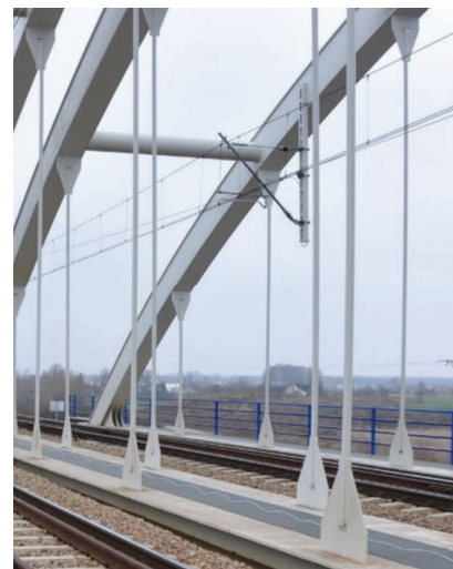
4. Widok wieszaków i blach węzłowych
