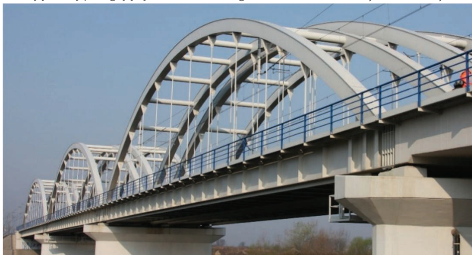
3. Widok mostu z boku
