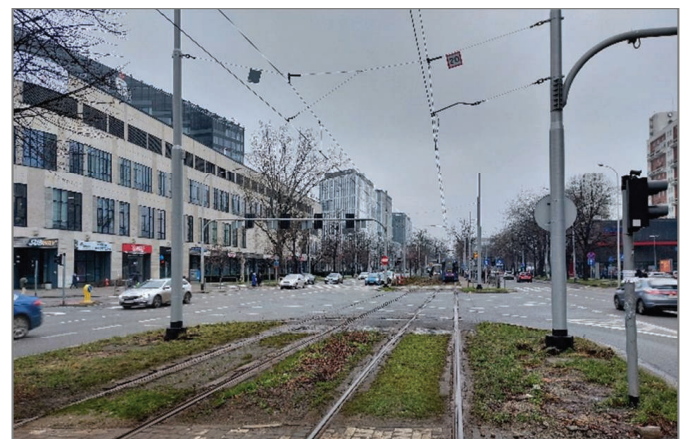
16. Ul. Powstańców Śląskich, skrzyżowanie z ul. Wielką, widok od Ronda. Ograniczenie do 20km/h wprowadzone w ramach realizowanego zadania pn. „Pionowanie słupów trakcyjnych na ul. Powstańców Śląskich we Wrocławiu” w dniach 9.11.2022-23.01.2023.
