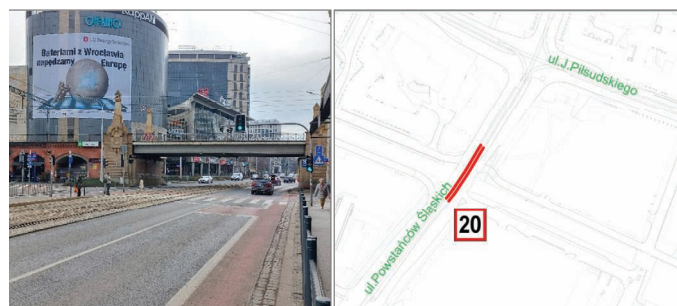
6. Ul. Powstańców Śląskich, widok od ul. J. Piłsudskiego. Ograniczenie prędkości do 20km/h obowiązujące na długości przejazdu pod wiaduktem
