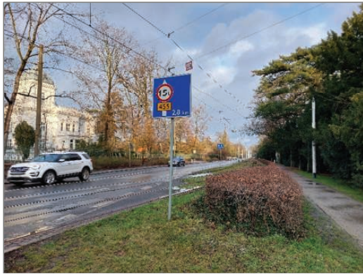
11. Ul. Mickiewicza, widok od ul. Wystawowej. Ograniczenie do 20km/h obowiązujące na długości od ul. Wystawowej do ul. Paderewskiego. Z uwagi na stan tor jest wyłączony z eksploatacji i wykorzystywany wyłącznie do jazdy awaryjnej lub na potrzeby objazdów. Dodatkowo na długości skrzyżowania z ul. Kopernika obowiązuje ograniczenie do 10km/h
