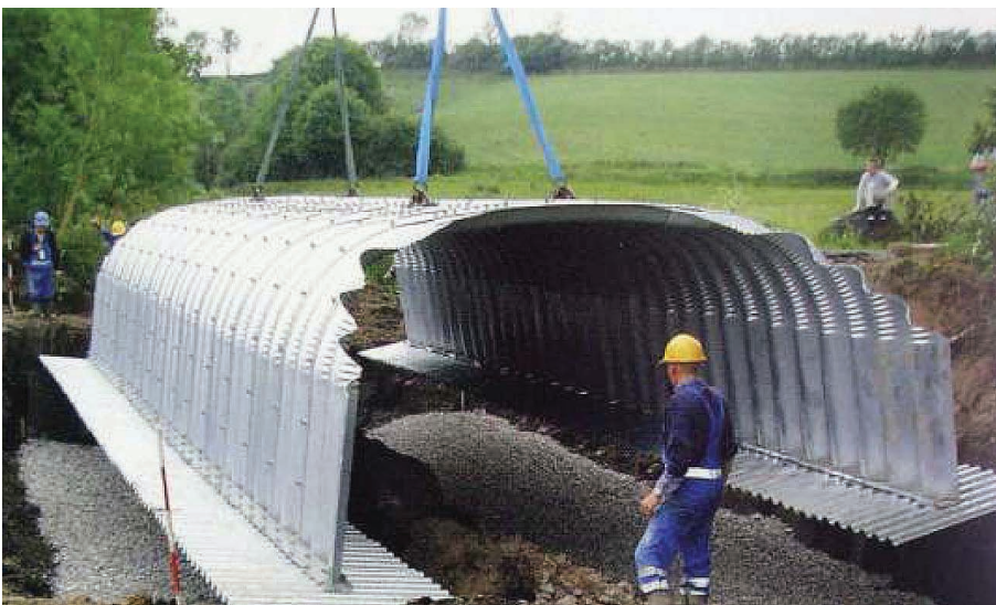
3. Konstrukcja powłoki z podparciem na blasze falistej [5]
