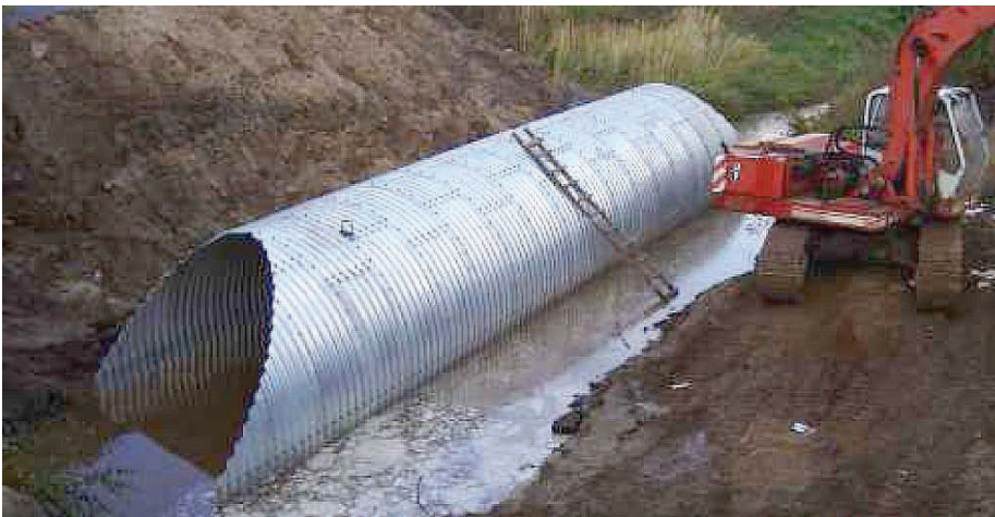
1. Realizacja budowy obiektu w cieku wodnym
