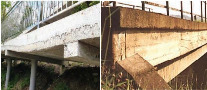
10. Deformacje w postaci: nieprawidłowej geometrii konstrukcji (po lewej) oraz zmiany geometrii osi elementu - trwale wygięcie konstrukcji przęsła (po prawej)
