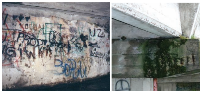
14. Zanieczyszczenia nieorganiczne neutralne (po lewej) oraz powierzchniowe zanieczyszczenia organiczne w postaci glonów (po prawej)
