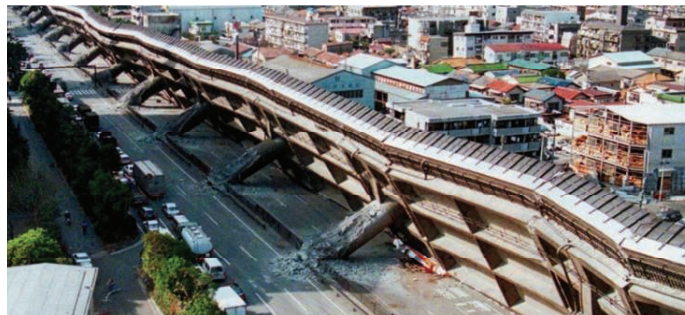
15. Zmiana położenia (obróć) całej konstrukcji mostowej w wyniku trzęsienia ziemi, połączona z deformacjami oraz ubytkami i utratą ciągłości materiału
