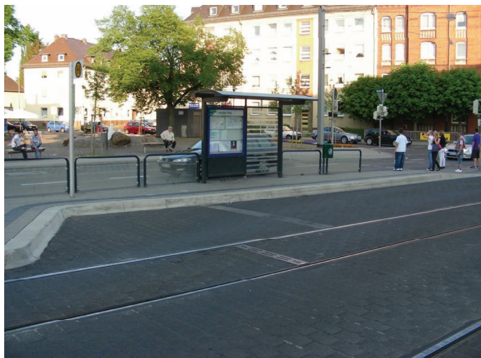
5. Kassel, Leipzigerplatz – przykład przyległych do siebie, niezależnych krawędzi peronowych dla autobusu (w środku zdjęcia) i tramwaju (niewidoczne, po lewej stronie)
