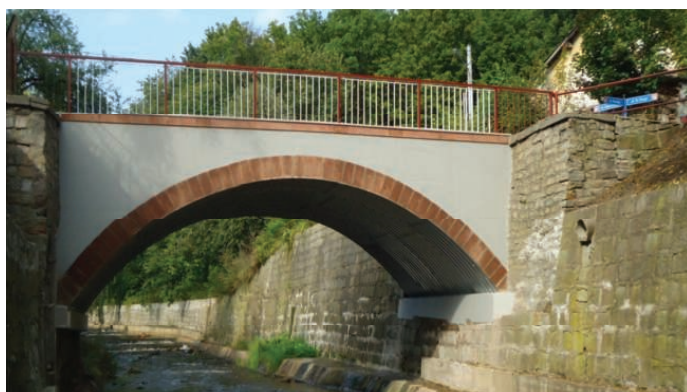
5. Elewacja kamiennego obiektu murowanego po remoncie [6]
