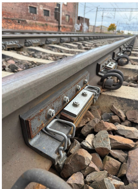
1. Absorber H i jego mocowanie do szyny [opracowanie własne]
