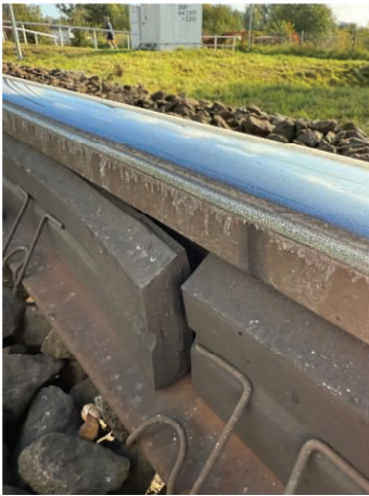
3. Przykład niewłaściwego przylegania izolatora przyszynowego [opracowanie własne]
