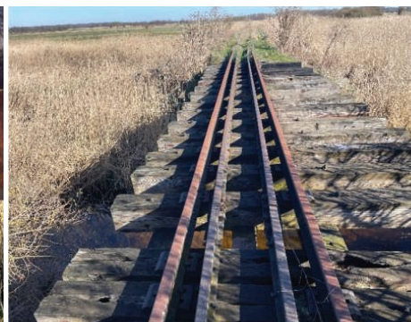
6. Stan istniejącego mostu kolejowego w km 3+622: ustrój nośny (rys. lewy), nawierzchnia na obiekcie (rys. prawy). Źródło: [Opracowanie własne]
