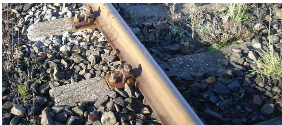
4. Nawierzchnia kolejowa z podkładami typu INBK-7 (materiały własne Autora)
