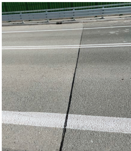
7. Widok nawierzchni śrutowanej, fot. autorskie
