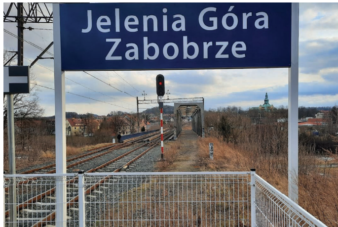
4. Most kolejowy na rzece Bóbr widoczny z przystanku – widoczny przebieg w miejscu proponowanego dojścia
