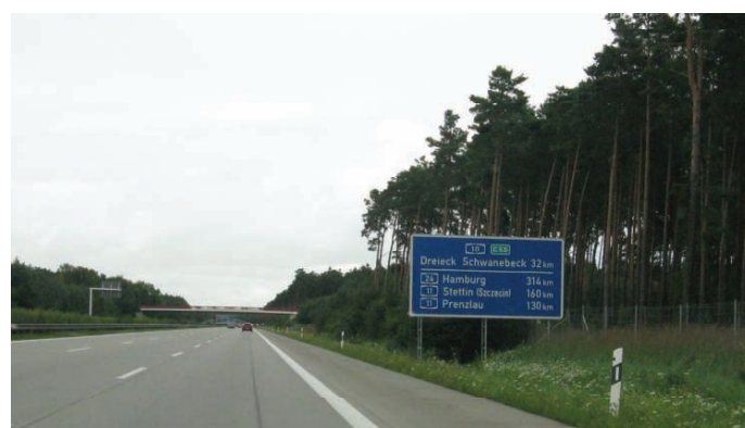
8. Tablica szlaku drogowego na autostradzie A10 w Niemczech
