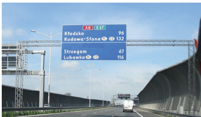
5. Tablica szlaku drogowego na autostradzie A8 w rejonie węzła „Wrocław Północ”
