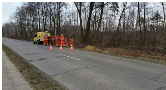
6. Stan spękań nawierzchni betonowej na drodze wojewódzkiej DW102
