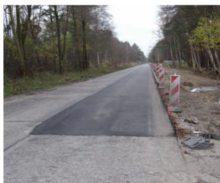
9. Warstwa SAMI ułożona na powierzchni skropionej emulsją
