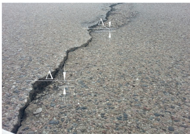
7. Różnice rzędnych w istniejącej nawierzchni: a) wykres ramka-wąsy przedstawiający oszacowanie statystyczne wyników pomiarów różnicy rzędnych \Delta ; b) ilustracja pomiaru różnicy rzędnych \Delta . Oznaczenia: \Delta_{50} – mediana różnicy rzędnych; \Delta_{85} - \Delta_{50} – trzeci kwantyl różnicy rzędnych ( \Delta_{85} - 85\% kwantyl odnotowanych różnic rzędnych, oznaczający, że 85% odnotowanych pomiarów nie przekracza tej wartości); \Delta_{50} - \Delta_{25} – drugi kwantyl różnicy rzędnych ( \Delta_{25} - 25\% kwantyl odnotowanych różnic rzędnych, oznaczający, że 25% odnotowanych pomiarów nie przekracza tej wartości)
