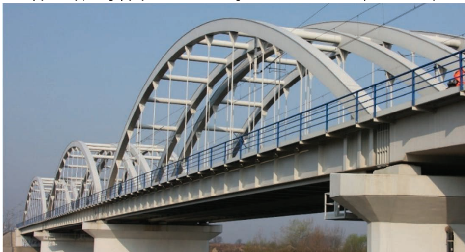
3. Widok mostu z boku
