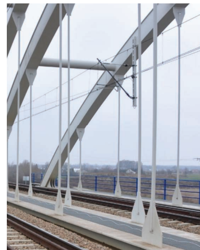
4. Widok wieszaków i blach węzłowych
