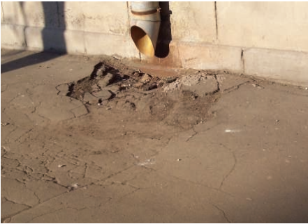
1. Pęknięcia siatkowe i blokowe oraz ubytki – przykład uszkodzenia nawierzchni asfaltowej wskutek braku prawidłowego odprowadzenia wody opadowej, a następnie działania mrozu
