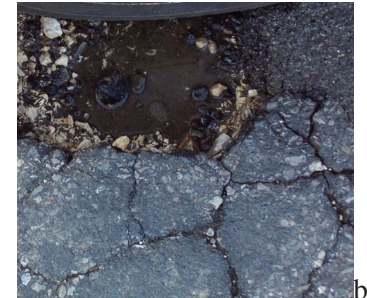
4. Wyboje: a) Fragment nawierzchni drogowej ze znacznymi ubytkami w warstwie ścieralnej z betonu asfaltowego, jak również w warstwie wiążącej i w podbudowie; b) koło pojazdu zagłębione we wgłębny ubytek wierzchniej warstwy drogowej sięgającej do podbudowy, z widocznymi zastoinami roztworu
