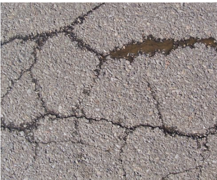
1. Pęknięcia siatkowe i blokowe oraz ubytki – przykład uszkodzenia nawierzchni asfaltowej wskutek braku prawidłowego odprowadzenia wody opadowej, a następnie działania mrozu
