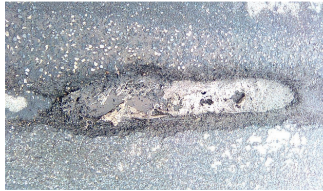
3. Wyboje/ubytki/dziury – przykłady rozległych, powierzchniowych uszkodzeń warstwy ścieralnej z betonu asfaltowego: warstwa ścieralna oddzielona tkaniną od warstwy wiążącej: a) uszkodzenie wgłębne w kształcie eliptyczno-kołowym ze znaczną ilością roztworu, b) uszkodzenie wgłębne w kształcie kołowym z roztworem w warstwie wiążącej, c) uszkodzenie wgłębne nawierzchni w kształcie eliptyczno-podłużnym z widocznym fragmentem soczewki lodowej (z lewej) – uwidoczniona erozja wgłębna warstwy wiążącej pod uszkodzoną warstwą tekstylną
