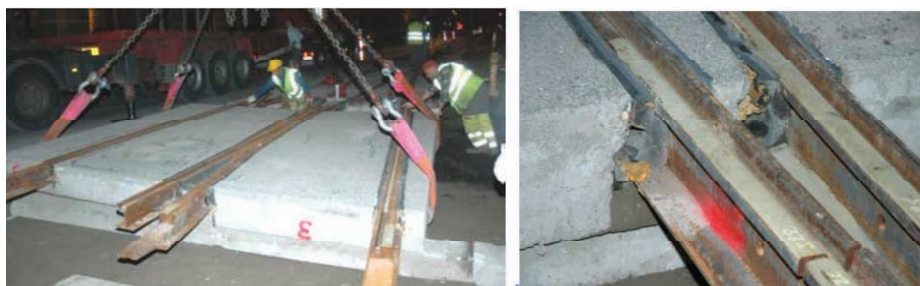
2. Montaż i zabudowa rozjazdu w płycie prefabrykowanej – Bruksela [5]
