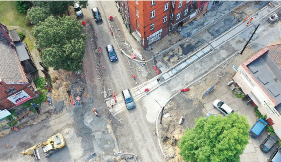
3. Prototypowa zabudowa rozjazdu w płytach prefabrykowanych w Bytomiu
