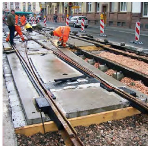
1. Montaż i zabudowa rozjazdu w płycie prefabrykowanej – Frankfurt 2008 [4]
