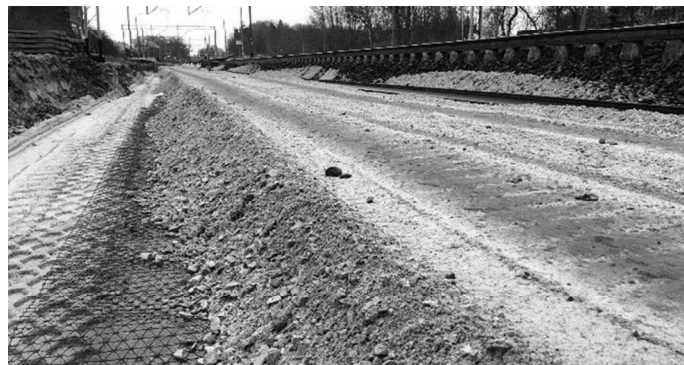
11. Stabilizacja warstwy ochronnej w trakcie modernizacji linii LK 273
