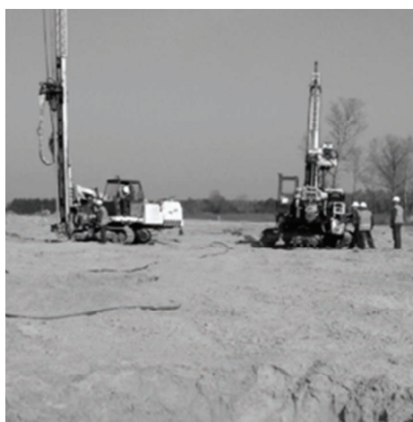
10. Metoda wzmacniania podłoża za pomocą środków strzałowych, autostrada A2 odcinek Koło-Dąbie [9]
