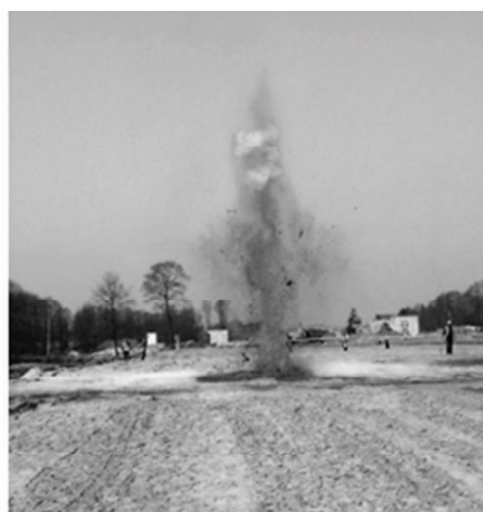
10. Metoda wzmacniania podłoża za pomocą środków strzałowych, autostrada A2 odcinek Koło-Dąbie [9]
