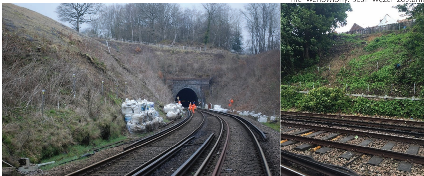
2. Instalacja czujników wykrywających osuwanie skarp w dwóch rzędach
