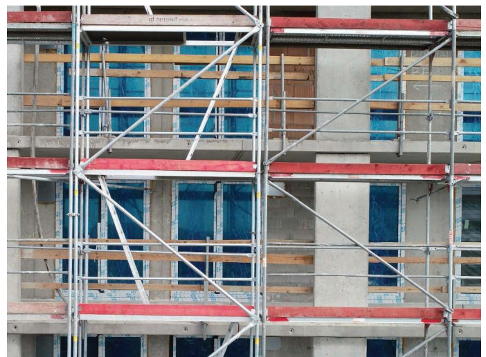
2. Widok na pion stępujący rusztowanie
