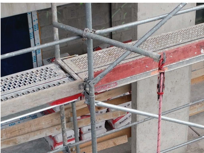
3. Widok na wciągarkę
