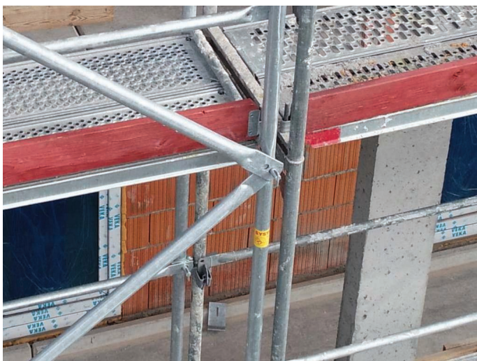
1. Widok na szczegół konstrukcyjny rusztowania – połączenie
