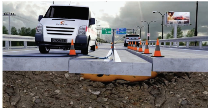
2. Zastosowanie iniekcji geotechnicznej do unoszenia płyty w nawierzchni betonowej
