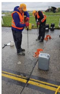
6. Nawiercenie otworów iniekcyjnych o średnicy 14-16 mm (zgodnie z wytyczoną siatką)
