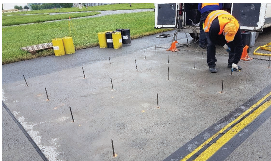
7. Osadzenie w nawierconych otworach, stalowych lanc iniekcyjnych
