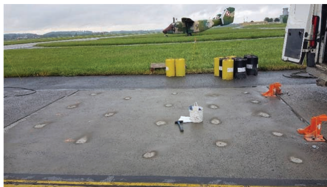
6. Nawiercenie otworów iniekcyjnych o średnicy 14-16 mm (zgodnie z wytyczoną siatką)
