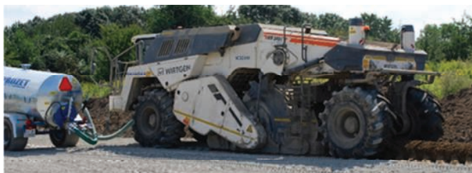
8. Proces mieszania gruntu rodzimego ze środkiem chemicznym
