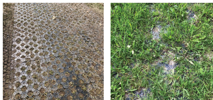
13. Widok kraty lotniskowej zaraz po wciśnięciu oraz po miesiącu
