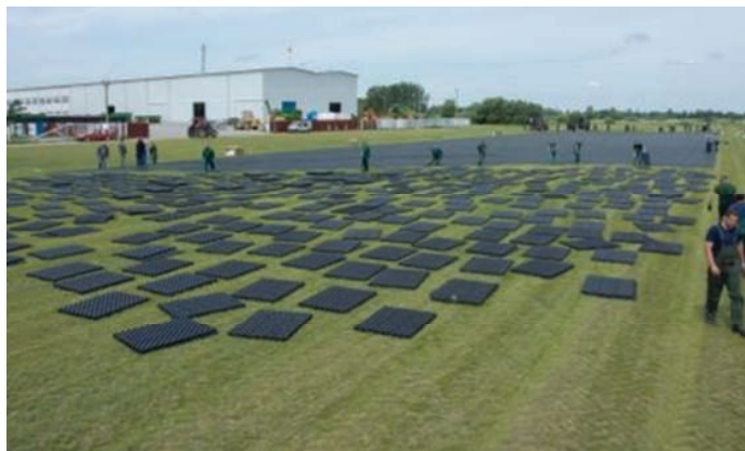
10. Układanie kraty na trawiastej nawierzchni drogi startowej [11]
