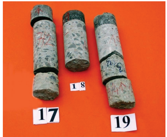
3. Przykłady rdzeni z wierć w nawierzchni Taxiway DK-A4
