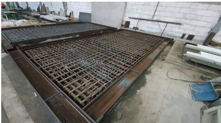
1. Proces produkcji płyt prefabrykowanych
