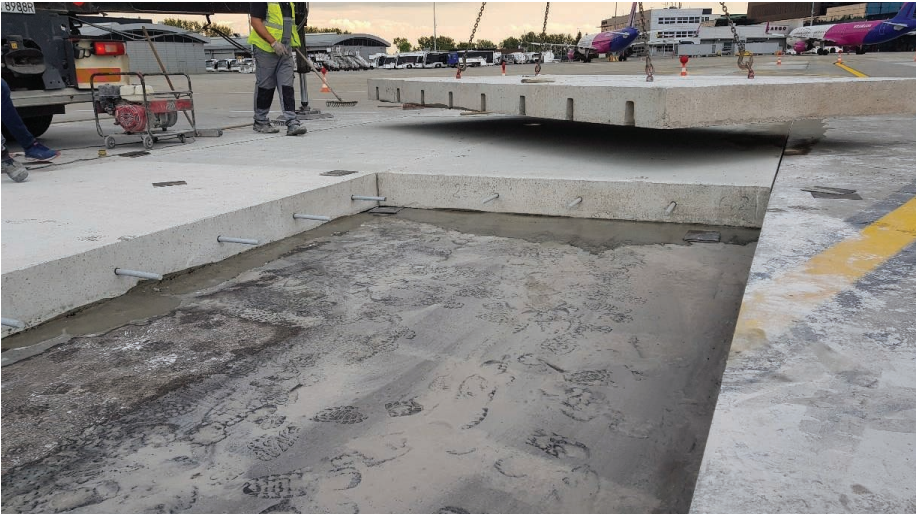
3. Montaż płyty z kieszeniami
