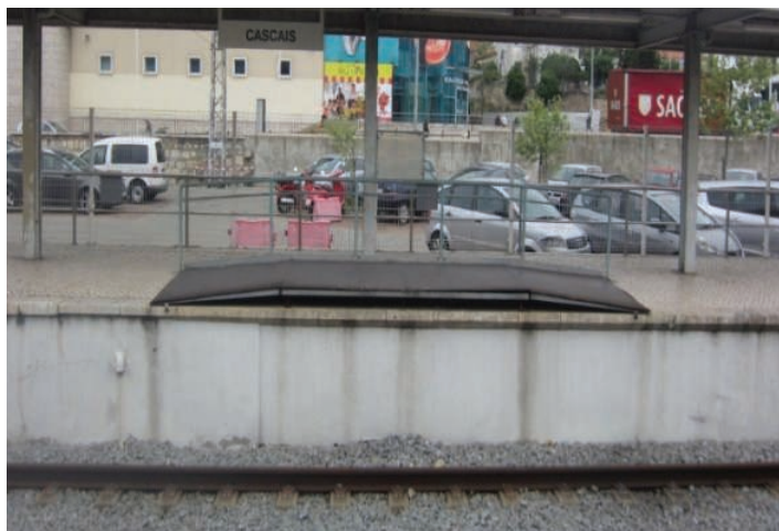
4. Podwyższenie części peronu (a) oraz przenośny podnośnik peronowy (b)
