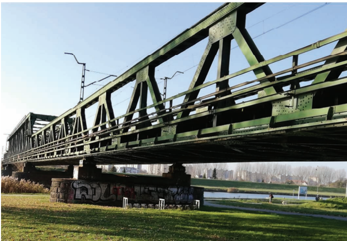
1. Widok ogólny mostu kolejowego przez Odrę w Opolu
