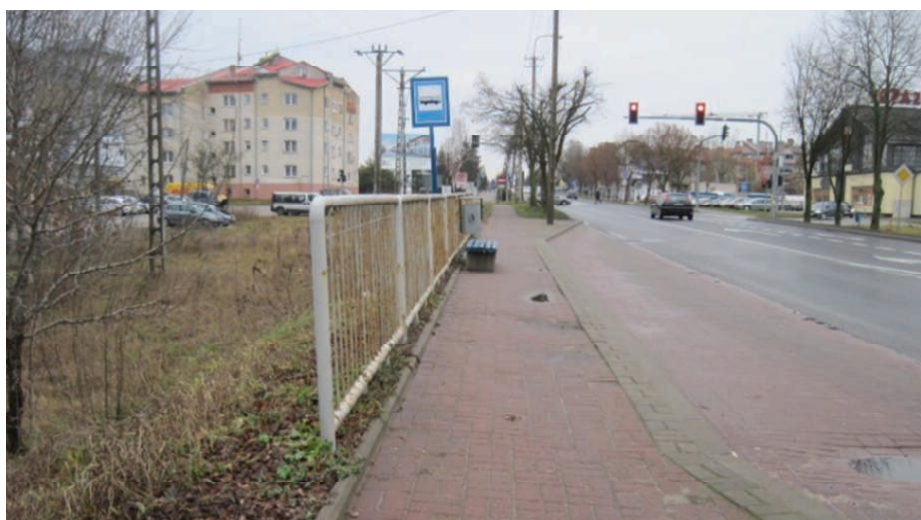
6. Peron przystanku o minimalnej szerokości (150 cm), zlokalizowany na skarpie z balustradą zabezpieczającą, która uniemożliwia osobie na wózku wykorzystanie terenu przylegającego
