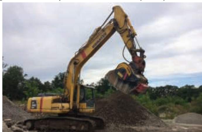
2. Widok kruszarki montowanej do ramienia koparki
