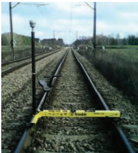
8. Zestaw GEDO do pomiaru torów metodą GNSS
