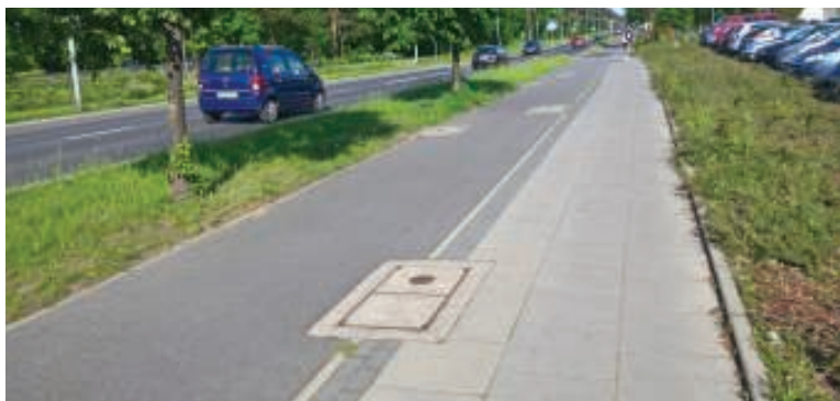
7. Studzienki kanalizacyjne na ścieżce rowerowej (ul. Struga Andrzeja, Prawobrzeże). Źródło: opracowanie własne
