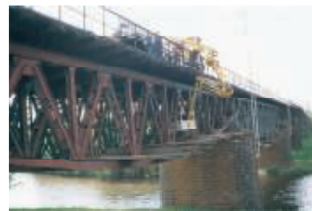
2. Przeгляд szczegółowy kratowych dźwigarów przęsła mostu
