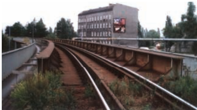
1. Wiadukt blachownicowy z pomostem stalowym bez podsypki
