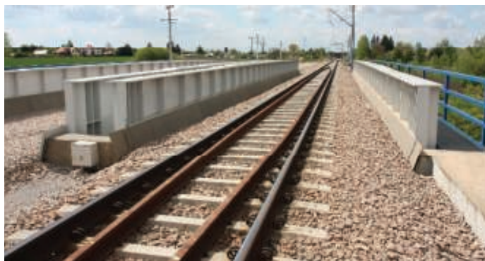
3. Most blachownicowy z pomostem stalowym i torem ułożonym na podsypce
