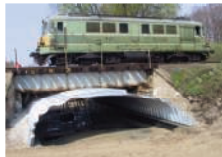
1. Przebudowa obiekt belkowego na gruntowo-powłokowy
