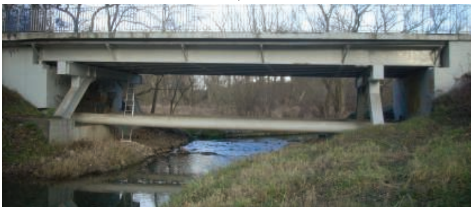
3. Widok ogólny mostu po wzmocnieniu
