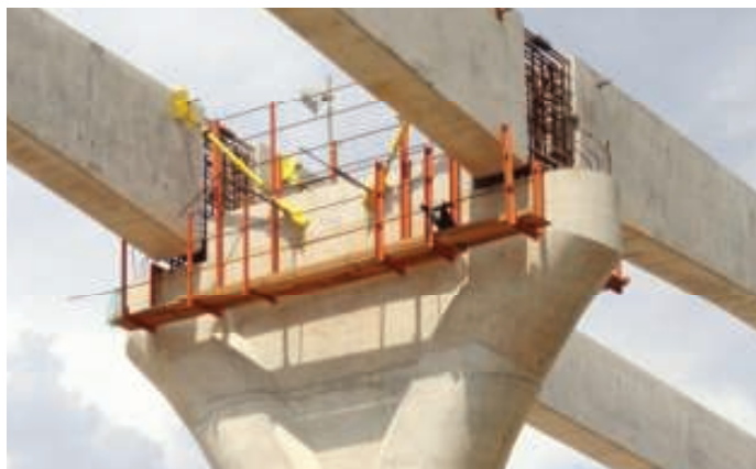
9. Stabilizacja dźwigarów po montażu na podporze [14]
