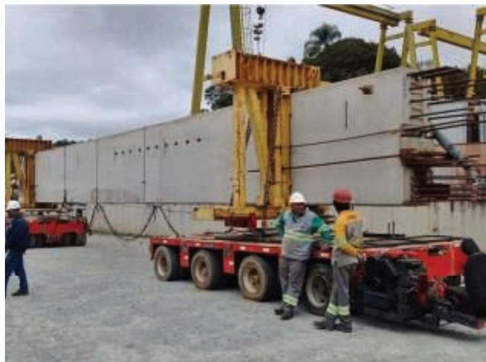
7. Naczepa transportująca dźwigar [12]
