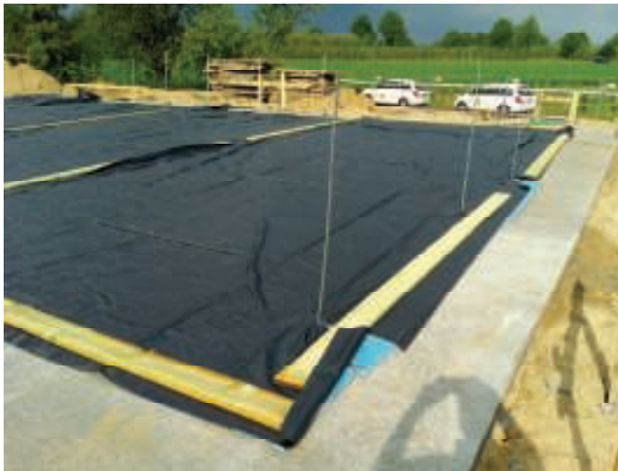
12. Elastomerowe maty wibroizolacyjne ułożone pod budynkiem (zdjęcie udostępnione przez PORR Polska Construction S.A)
