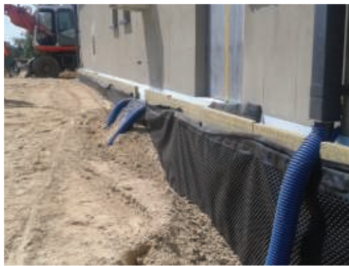
13. Maty wibroizolacyjne z wełny mineralnej (firmy Rock Delta) ułożone na styku ścian bocznych z gruntem (zdjęcie udostępnione przez PORR Polska Construction S.A.)
