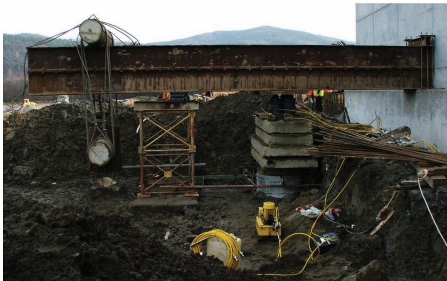
3. Stanowisko do próbnych obciążeń kolumny kamiennej
