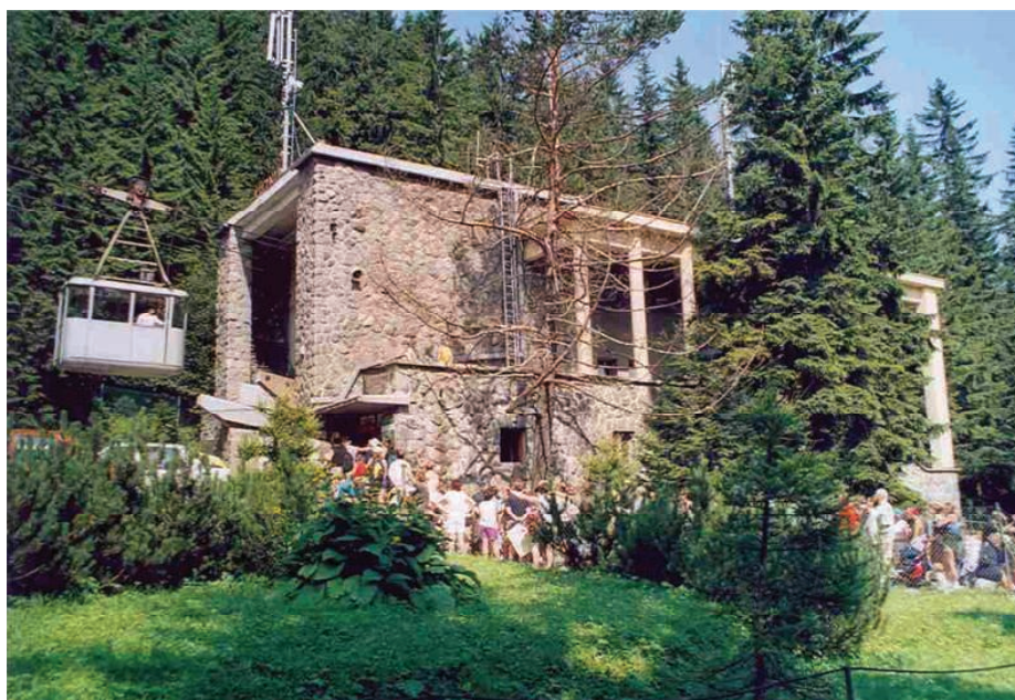
3. Widok stacji dolnej kolei (Kuźnice) przed modernizacją w 2007 r.
