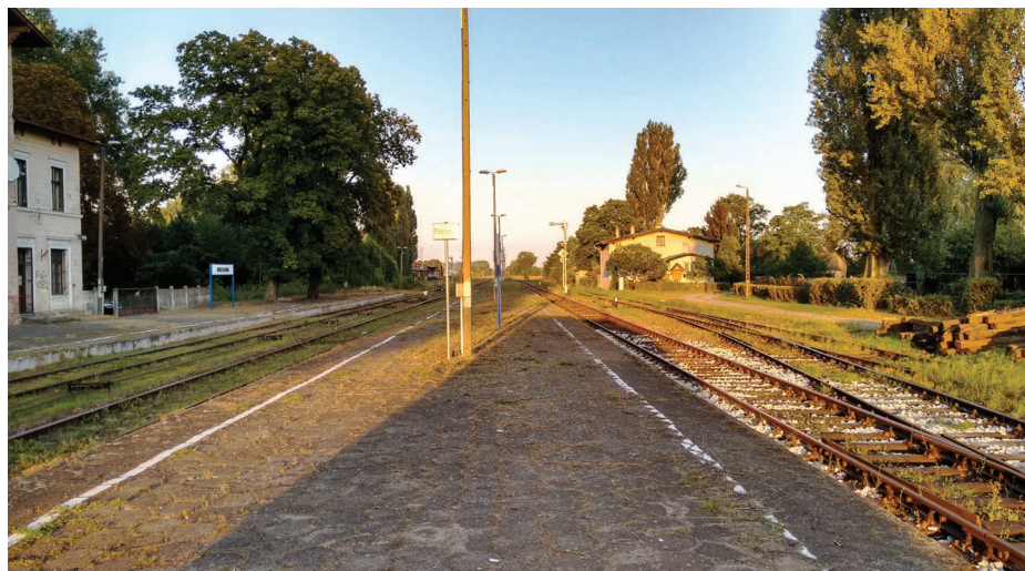
4. Postępująca modernizacja linii kolejowej Głogów-Wschowa-Leszno (stacja Wschowa). Źródło: fot. autor
