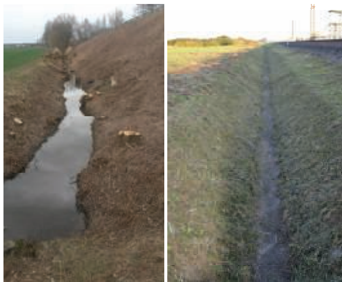
12. Prace konserwacyjne Przy nasypach i rowach odwadniających
