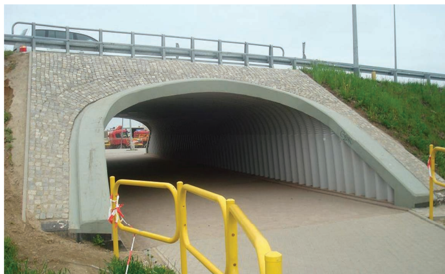
1. Widok drogowego obiektu gruntowo-powłokowego
