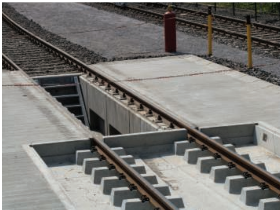
3. Przykład punktu utrzymania taboru – kanał inspekcyjny sytemu AG i wanna torowa sytemu GTW (Fot. BFL Lauchhammer)
