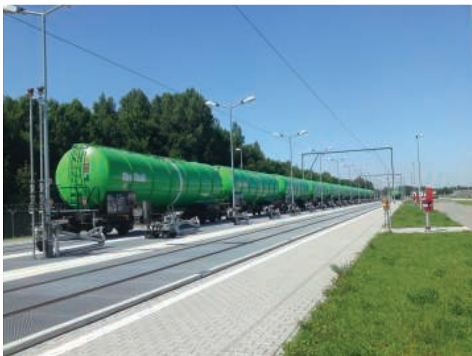
1. Przykład nowoczesnego frontu do przeładunku materiałów niebezpiecznych wykonanego z prefabrykowanych elementów bezpodsypkowej nawierzchni kolejowej płyt typu GTW (Fot. BFL Lauchhammer)
