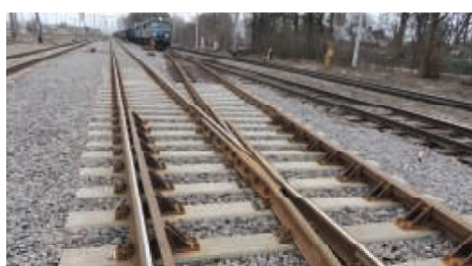
7. Widok zespołu krzyżownicy zwyczajnej rozjazdu Rkpd 60E1-190-1:9 produkcji KZN „Bieżanów” (fot. KZN „Bieżanów”)
