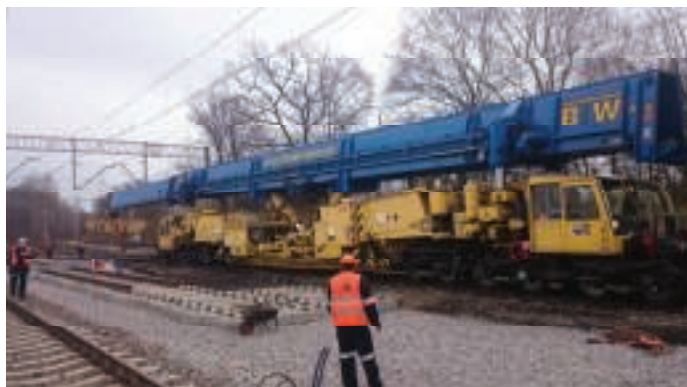
2. Zabudowa zwrotnicy rozjazdu Rkpd przy wykorzystaniu dźwigu Gotwald GS150.14.TR
