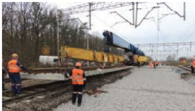
3. Zabudowa zwrotnicy rozjazdu Rkpd przy wykorzystaniu dźwigu Gotwald GS150.14.TR
