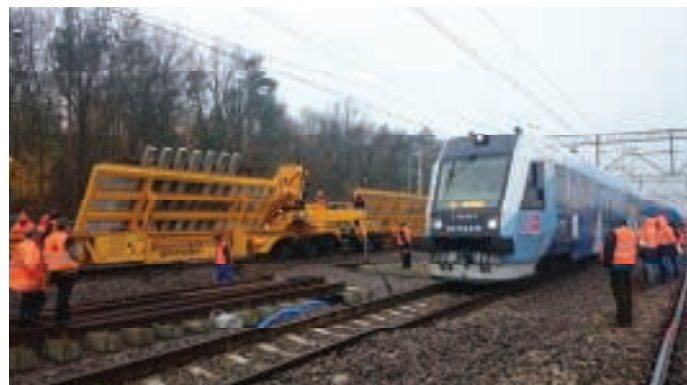
4. Dostarczenie na plac budowy krzyżownic zwyczajnych przy zastosowaniu platform typu „Switcher”
