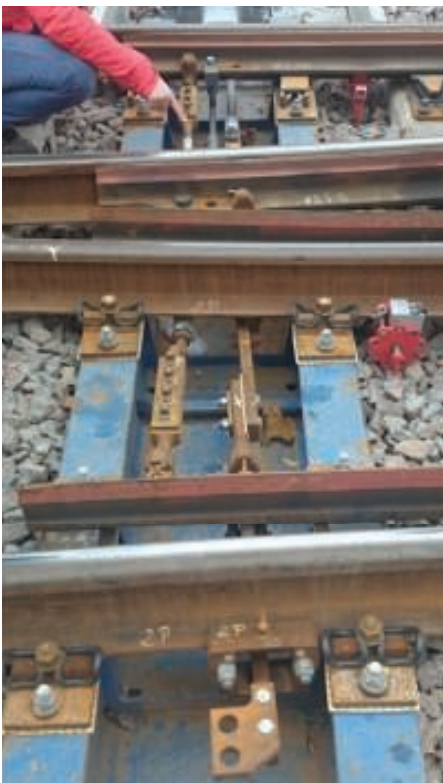
10. Podrozjazdница zespolona z zamknięciem nastawczym w rozjeździe firmy Track Tec KolTram Sp. z o.o.
