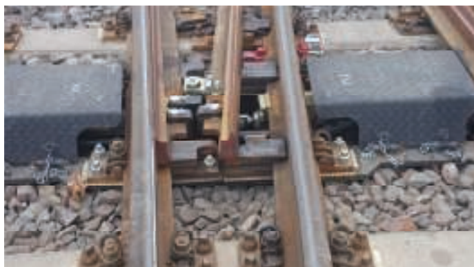
12. Fragment mocowania elementów zamknięcia nastawczego Spherolock w podrozdźdźnicy zespolonej rozjazdów Rkpd 60E1-190-1:9 firmy Vossloh Cogifer Polska Sp. z o.o.
