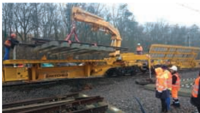
5. Zabudowa elementu krzyżownicy zwyczajnej za pomocą dźwigu platformy typu „Switcher”
