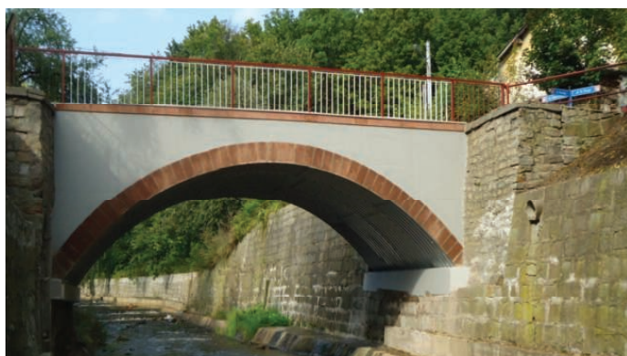
5. Elewacja kamiennego obiektu murowanego po remoncie [6]
