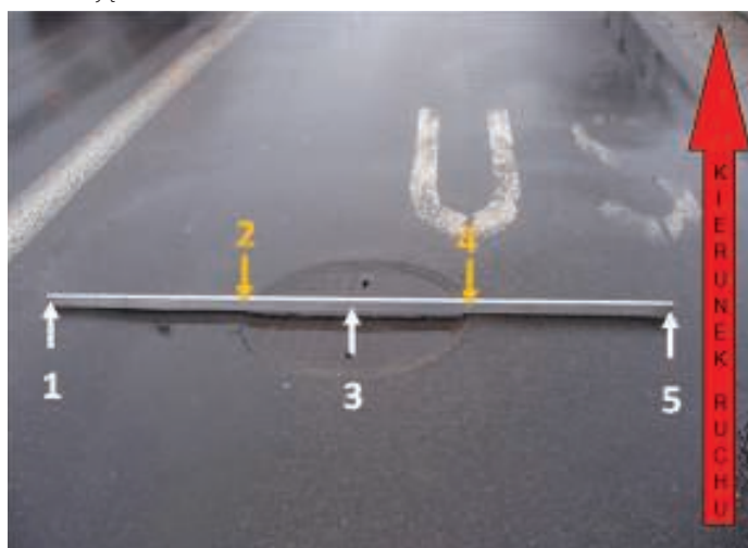
4. Sposób pomiaru deformacji studni – położenie A
