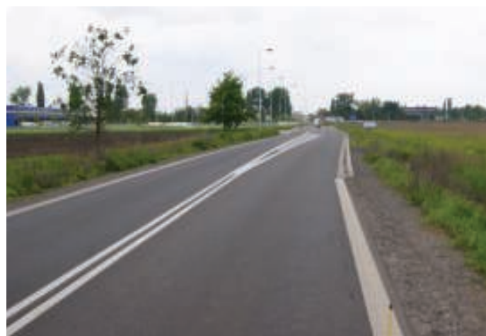
8. Odcinek doświadczalny po wykonanym remoncie – stan zerowy
