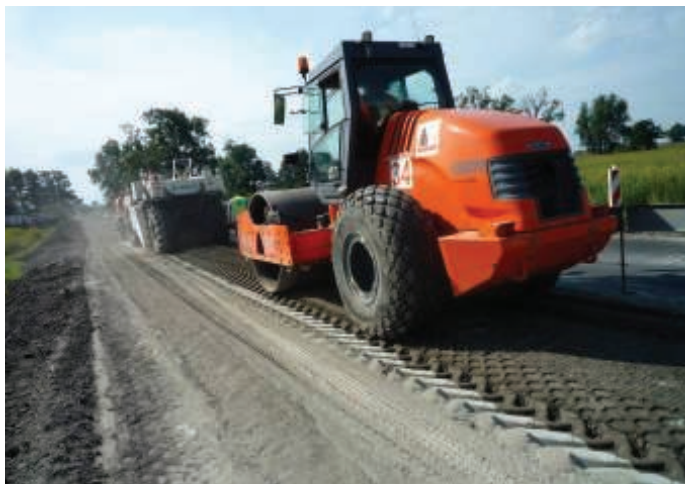
7. Zagęszczanie warstwy MCE
