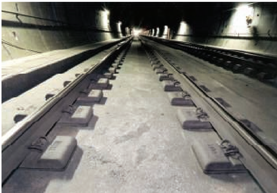
2. Nowoczesna, bezpodsytkowa nawierzchni torowa
